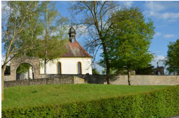
BILD 1, Friedhof Mönchsondheim, Mauer und Friedhofskapelle
