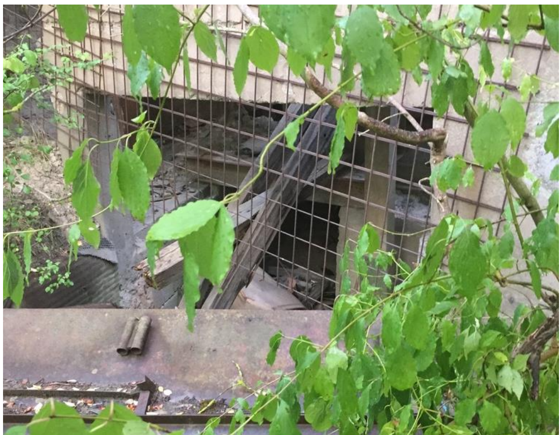
Abb. 3: Altes Betriebsgebäude, Einflugmöglichkeit West/Nordwest
