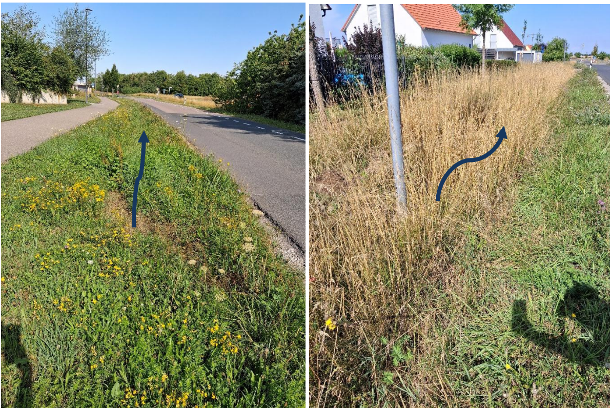
Abbildung 8: breitflächige Einleitung über Schulter des Straßenseitengrabens mit sehr flachem Sohlgefälle
