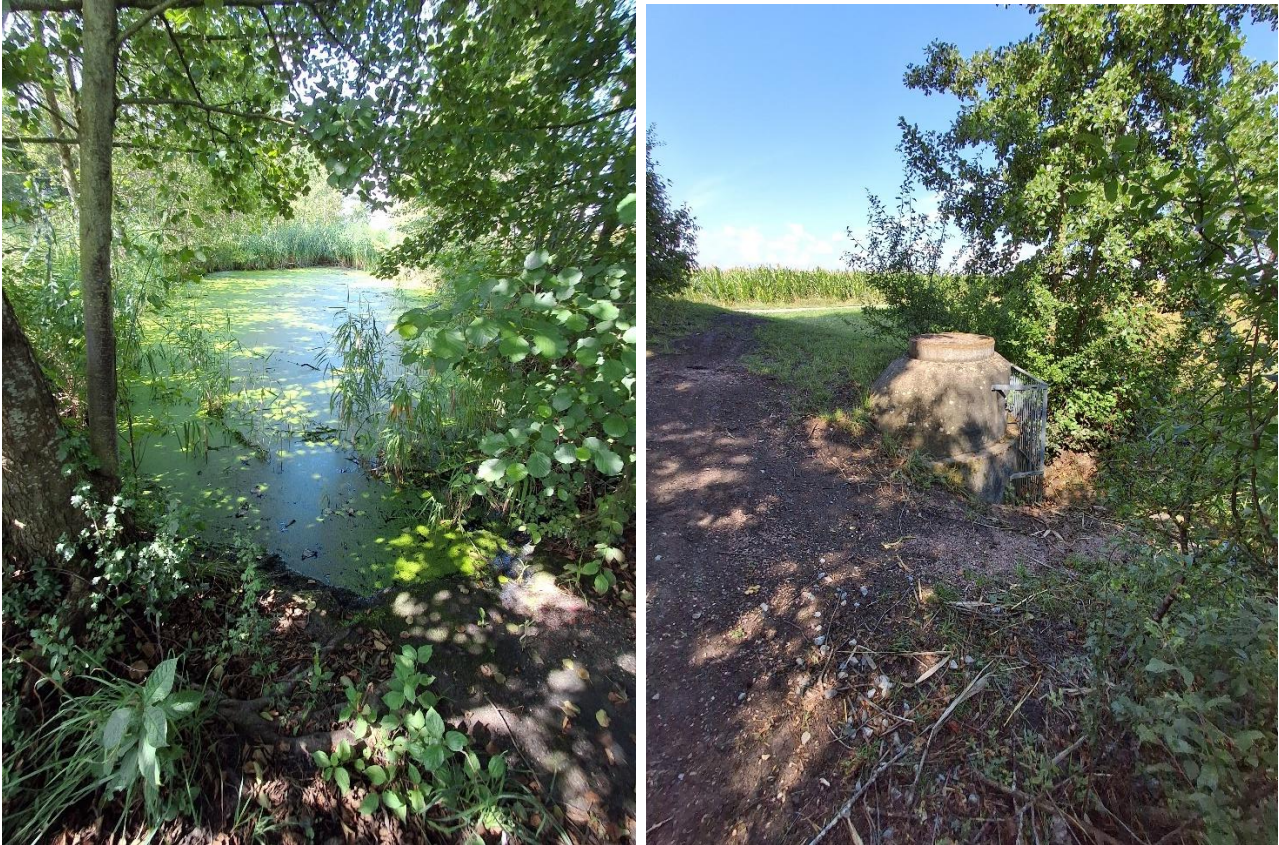
Abbildung 2: RRB mit Dauerstau und Ablaufbauwerk
