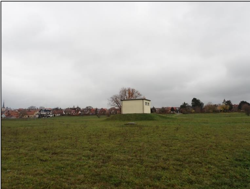
Abbildung 8: Blick vom Main in Richtung Horizontalfilterbrunnen Marktsteft (HFB M) bzw. Marktsteft
